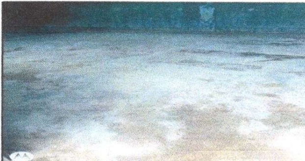
SUSTITUCIÓN DE PISO DE GRANITO A LAS AULAS DE MODULO 1
