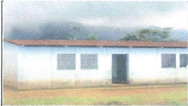
CUBIERTA DE LAMINA . SUSTITUCION DE LAMINA
