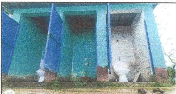
SUSTITUCIÓN DE TECHO, CAMBIO DE TAZAS, PISO Y PINTURA
