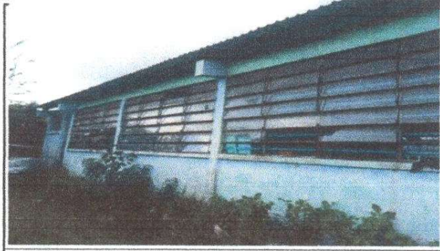
SUSTITUCION DE VIDRIOS, PISO Y PINTURA DE PUERTAS.
