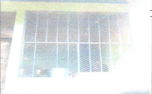
SUSTITUCIÓN DE VENTANA DE COCINA Y PISO
